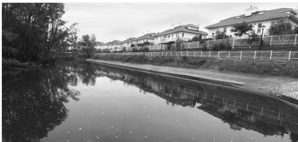
Rysunek 5.3.3. Zrekultywowany Staw Lipkowski retencjonujący wody opadowe z osiedla Laguna (fot. T. Stańczyk)
